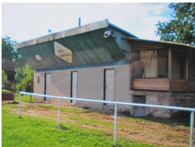
Objekt k demolicí
