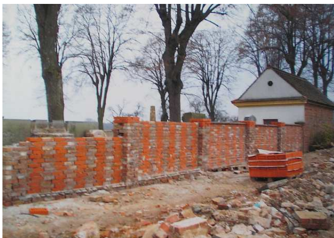
Oprava hřbitovní zdi - IV.etapa
