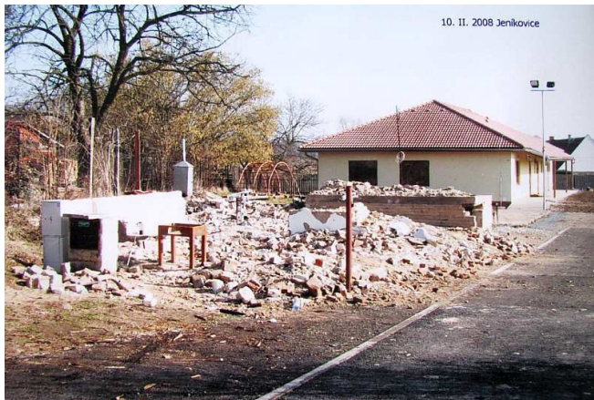
Demolice starých kabin
