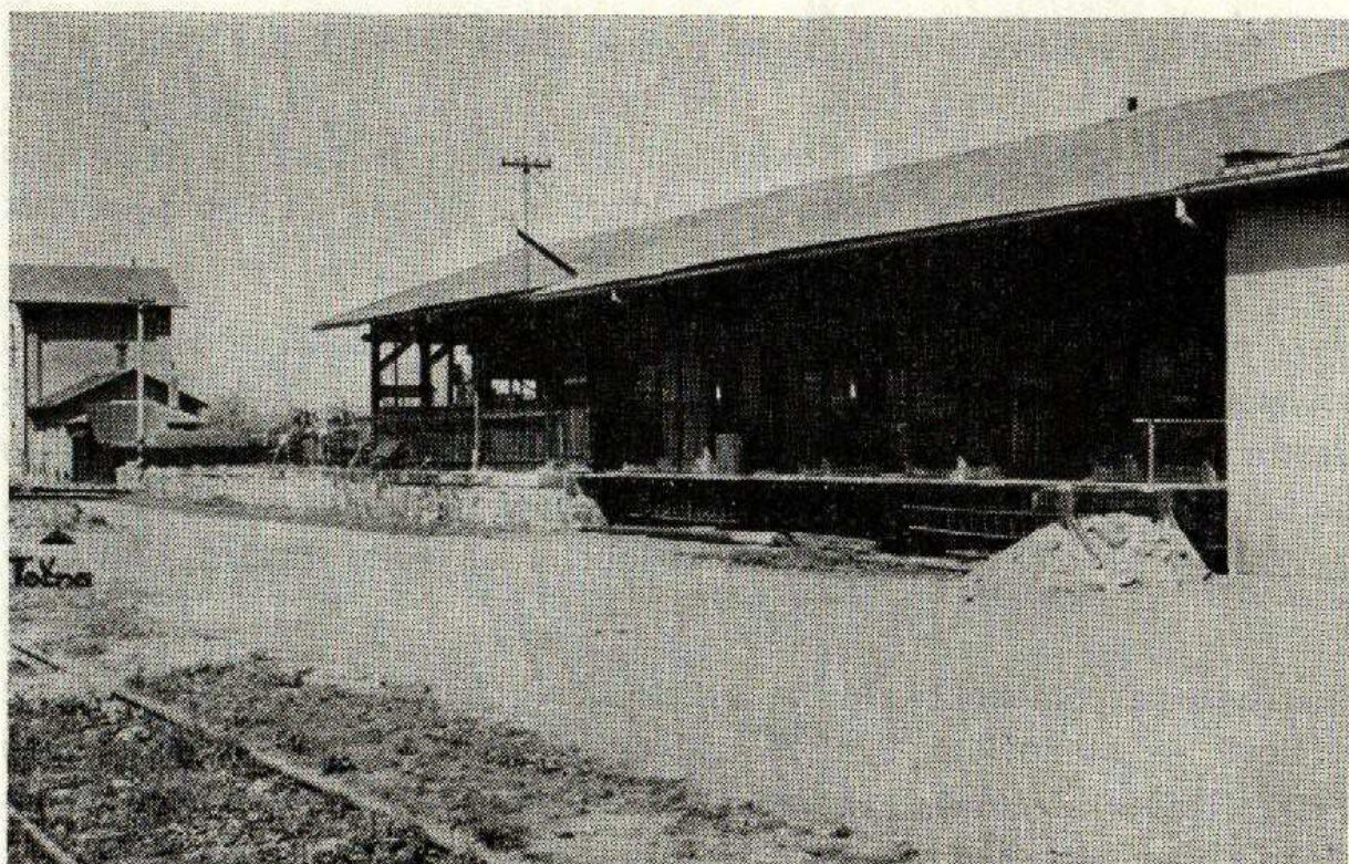
Společné tranzitní skladiště včetně rampy — ze strany státní dráhy, kde si zaměstnanci obou společností vzájemně předávali zboží s průvodními listinami k další přepravě po dráze sousední společnosti. V prostoru mezi rampou a vodárnou byly na obou skladištních kolejích dodatečně smontovány točny se spojovací koleji, aby i vozové zásilky mohly bez překládky zboží tranzitovat
